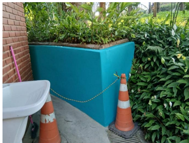
Figura 106: Reparo no registro do banheiro
