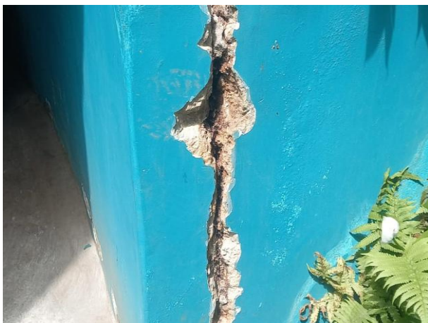
Figura 105: Reparo no registro do banheiro
