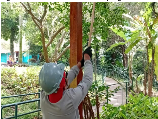
Figura 115: Pintura externa da administração
