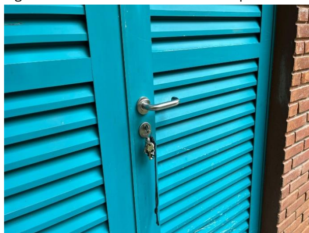
Figura 104: Restauração do muro com rachadura
