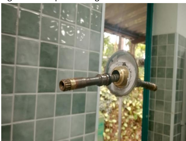
Figura 107: Implantação de torneira no bebedouro
