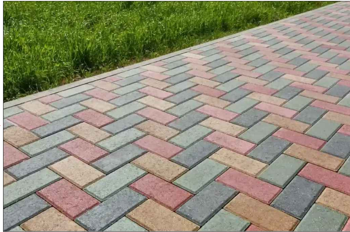
PAVIMENTO INTERTRAVADO DE CONCRETO
