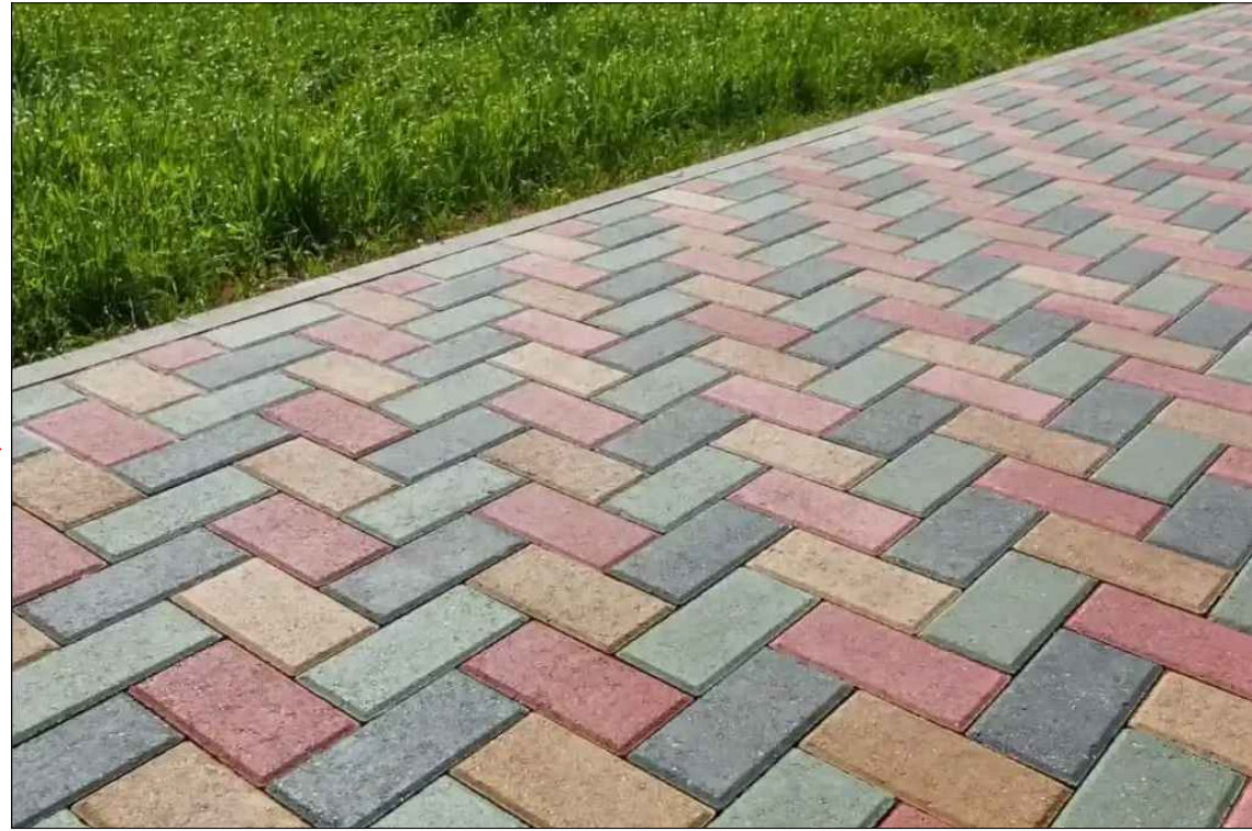
PAVIMENTO INTERTRAVADO DE CONCRETO
