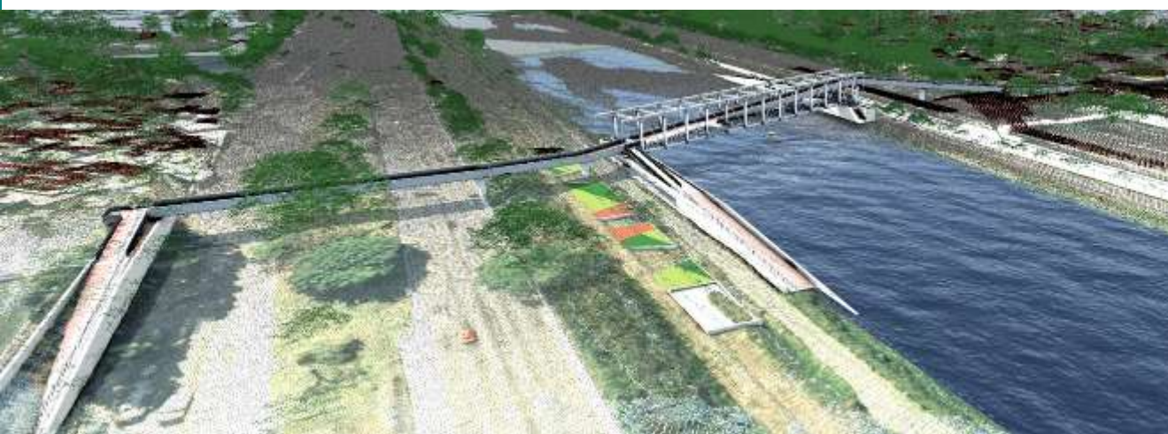
VISTA DA MARGEM OESTE
