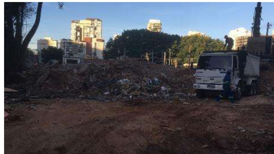
Demolição de imóveis expropriados entre a Rua Natividade e Rua Silvania
